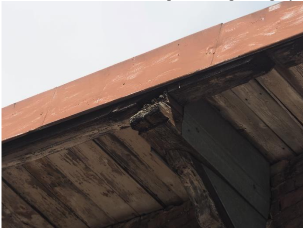
Fot. 8. Końcówki płatwi porażone przez grzyby, widoczne blachy wzmacniające wystające krokwie
