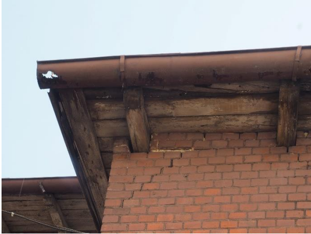
Fot. 13. Końcówki krokwi i odeskowania porażone przez grzyby. Dziurawe rynny przyczyną ogniska korozji biologicznej
