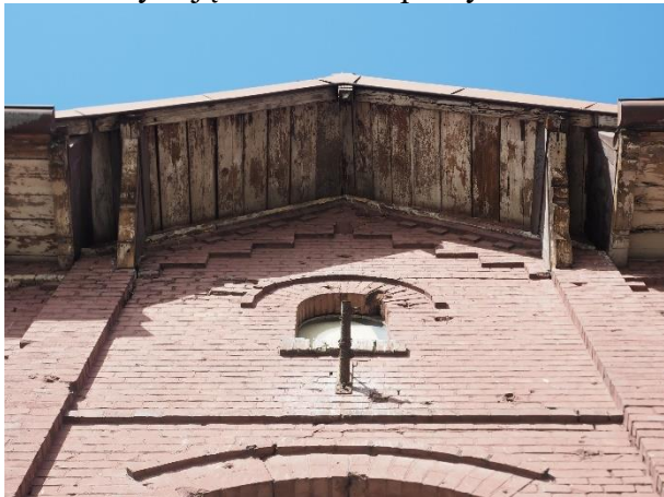
Fot. 3. Końcówki krokwi porażone przez grzyby
