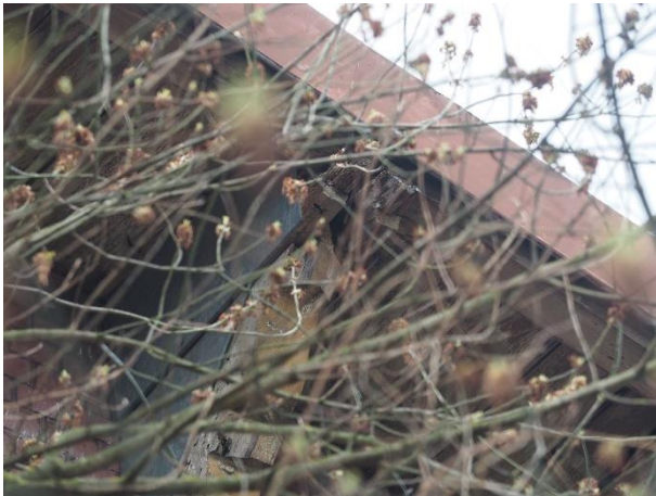
Fot. 17. Końcówki krokwi porażone przez grzyby
