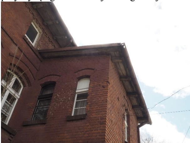
Fot. 14. Końcówki krokwi porażone przez grzyby
