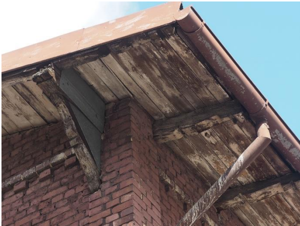
Fot. 7. Końcówki krokwi porażone przez grzyby
