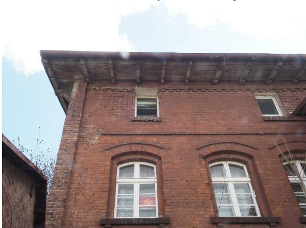
Fot. 12. Końcówki płatwi porażone przez grzyby
