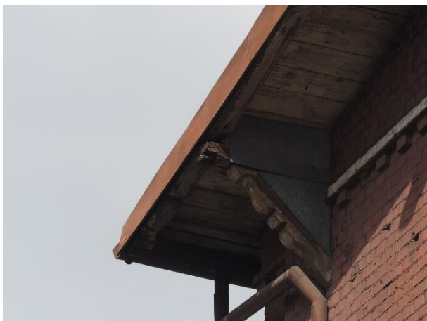
Fot. 10. Końcówki płatwi porażone przez grzyby, widoczne blachy wzmacniające wystające krokiew. Nierównomierne wystawanie płatwi względem muru
